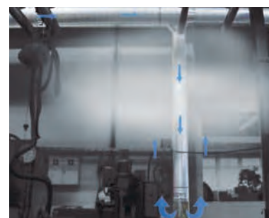
Výstupní potrubí zdroje
